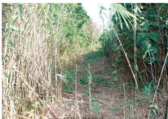
写真Ⅲ-3-4 石見銀山街道鞆ヶ浦道に含めようとする里道216mの状態
