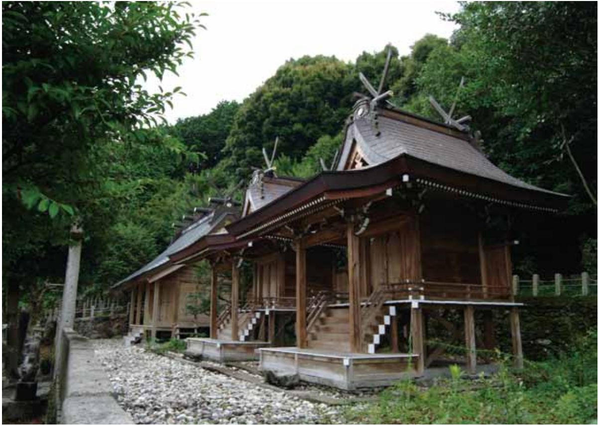
写真Ⅲ-2-2 高野参詣道三谷坂② 丹生酒殿神社 BIS-023-001 の状態
