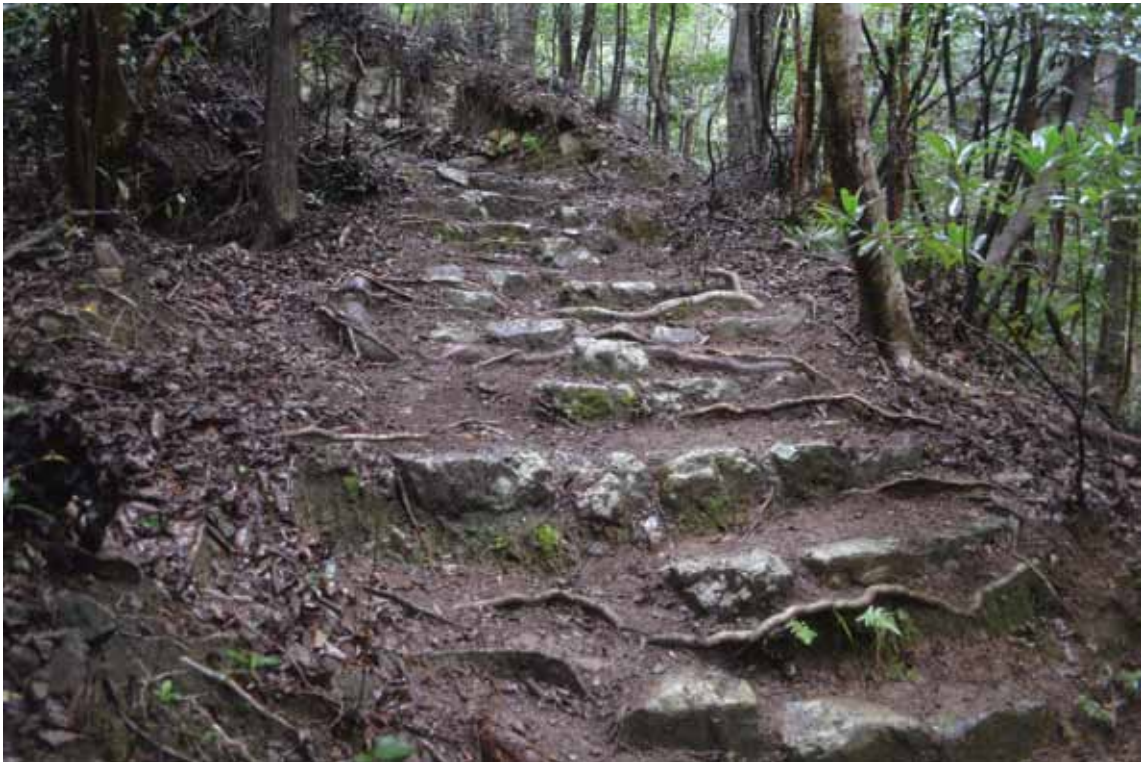
写真Ⅲ-1-17 熊野参詣道大辺路⑧ 駿田峠 BIS-021-009 の状態
