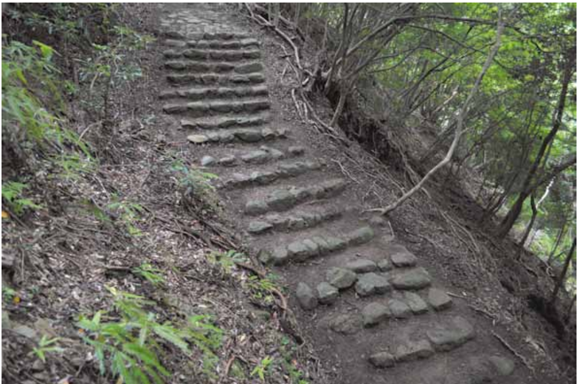
写真Ⅲ-1-13 熊野参詣道大辺路④ 富山平見道 BIS-021-004 の状態
